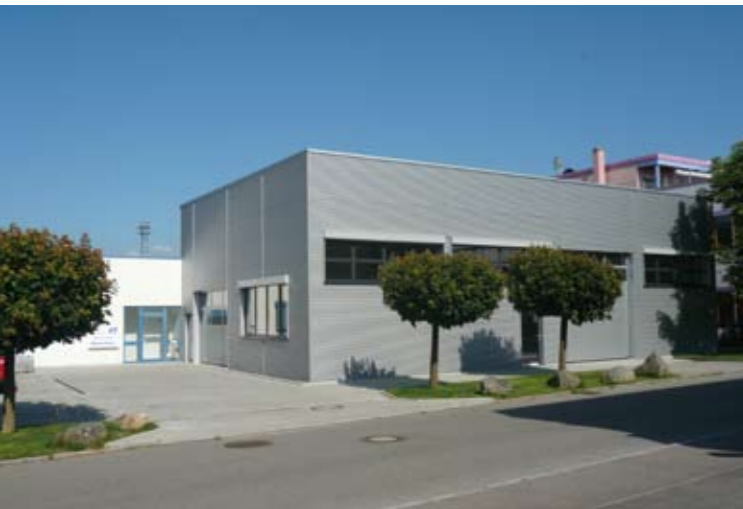
Für die neue Portalfräsmaschine hat Tetzlaff Modellbau eine Halle errichtet, die exakt auf die Höhe der FZ33 angepasst ist.
