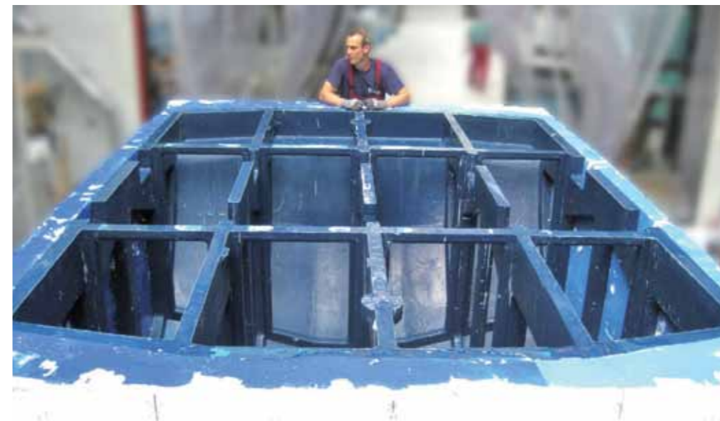
Die Konstruktion liegt frei – entgratet und gereinigt.
