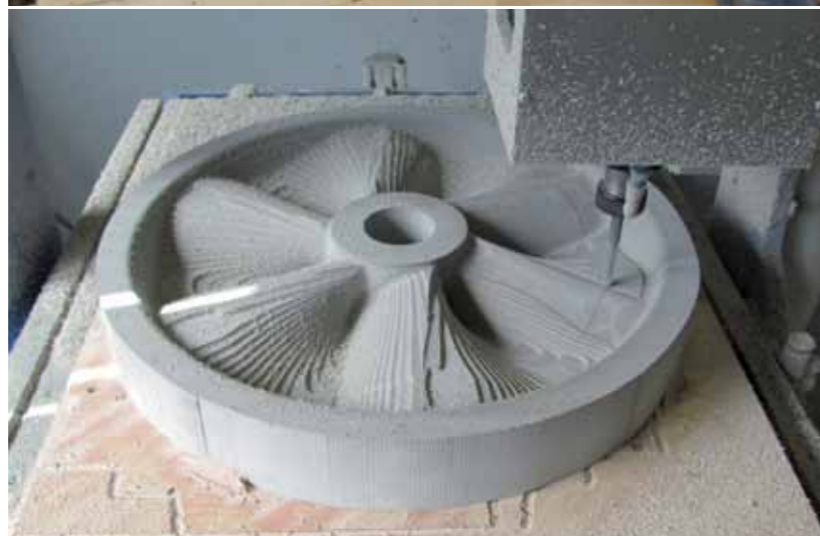
Fräsen eines Lüfterrades.
