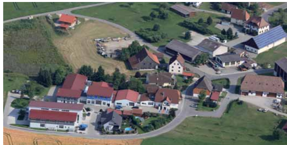
Das Betriebsgelände aus der Luft gesehen.
