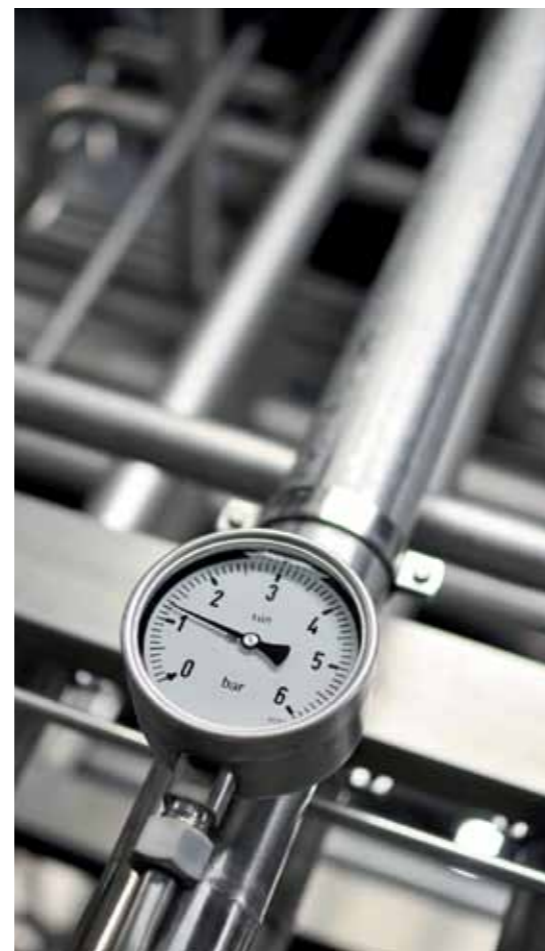
Gerade für kleine und mittlere Unternehmen bietet die Förderung einen Anreiz in Techniken zur Effizienzsteigerung zu investieren. Statt Förderkredite gibt es jetzt erstmals Investitionszuschüsse – einer langjährigen Forderung des Handwerks folgend. Bild: industrieblick - Fotolia
