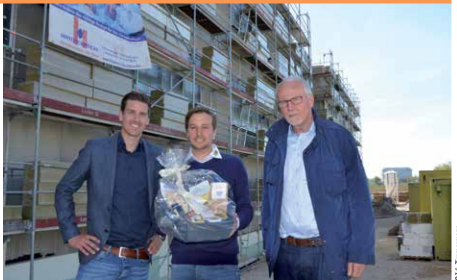
Mit der neuen Montagehalle bekennt sich F. Zimmermann klar zum Standort Neuhausen (v.l.): Frieder Gänzle, Prokurist und Gesellschafter bei F. Zimmermann, Matthias Wittlinger, stellv. Bauleiter, und Rudolf Gänzle, Vorsitzender der Geschäftsführung.
