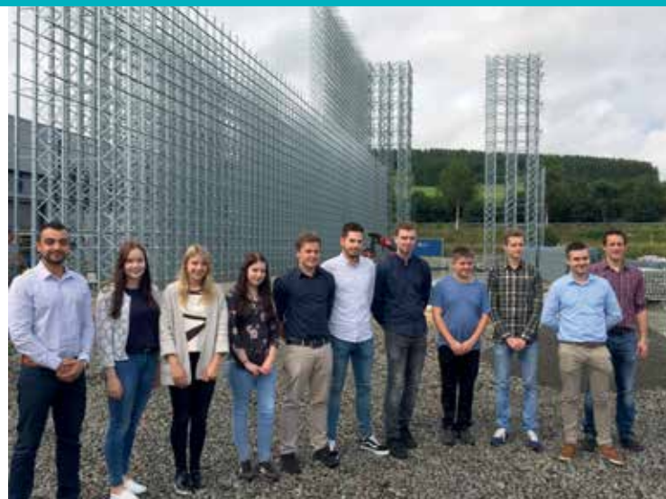
Die Zukunft von BIKAR vor der Zukunft von BIKAR: Im Vordergrund die neuen Auszubildenden, im Hintergrund die Baustelle des neuen Hochregallagers.
