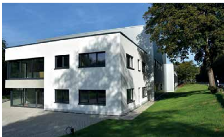
Der neue Anbau schafft Raum für Ideen, Mitarbeiter und Maschinen
