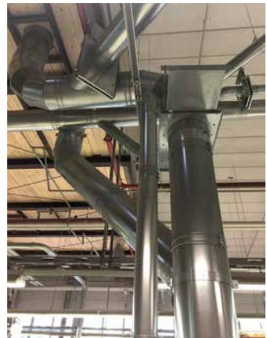
Rohrleitungssystem mit Absperrschiebern Bilder: Spänex
