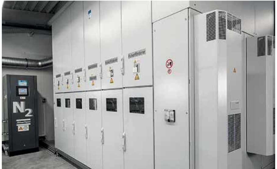
Auf der Rückseite der Anlage sind die Pulverförderer verbaut – sie können bequem von außen neu beladen werden.
