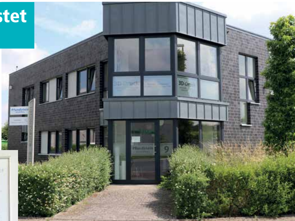
Vor dem Eingang eine Bienenwiese, auf dem Dach die PV-Anlage, die auch den E-Firmenwagen versorgt – das Unternehmen setzt auf Nachhaltigkeit.
